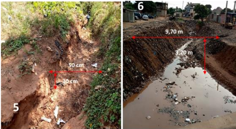
Planche 2: Photos 5 : Rigoles incisant les rues sur sol sablo-argileux; Photo 6: Ravin No 3 situé derrière l’EPP Adjougba 1, Source : AMEDEKA K. A., Photos prises en Septembre 2020
